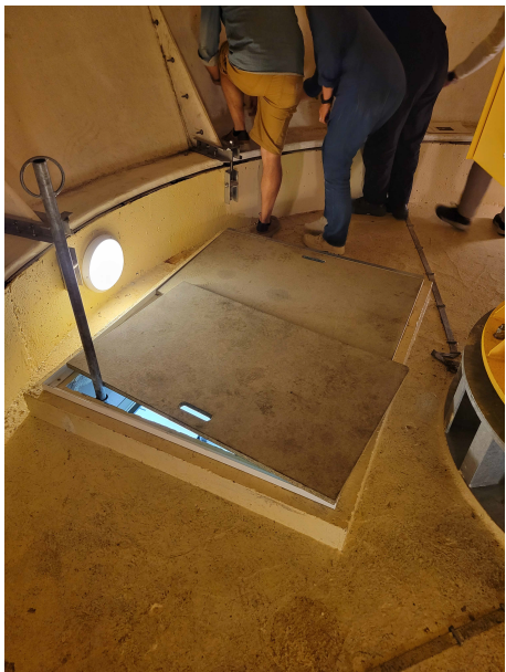
Dépose et évacuation des plaques de bois existante remplacé par une trappe métallique en tôle larmée ouverture manuelle et supportant 250kg/m²
