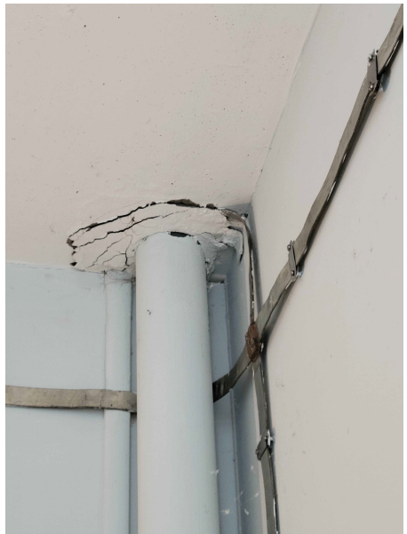
Reprise des dégradations dues aux infiltration d'eau. (salle radar / escaliers / Bureau RDC)
