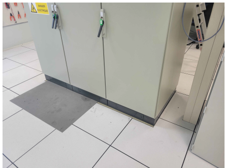
Remplacement et adaptation des dalles de faux plancher technique avec la mise en place de la nouvelle baie. (baie hors marché)
